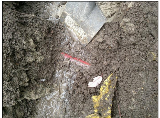
Vasen. Kaapeliojaa Kalkkistentien ja Laviantien risteuksen hilpeillä. Pusikon kohdalla on kivikasa, kaapeliojan reunalla näkyy isohko betonilohkare. Oikea. Kuitukaapeli maakaapelia varten kaivetussa ojassa Laviantien varressa Kalkkistentien risteuksen paikkeilla.
