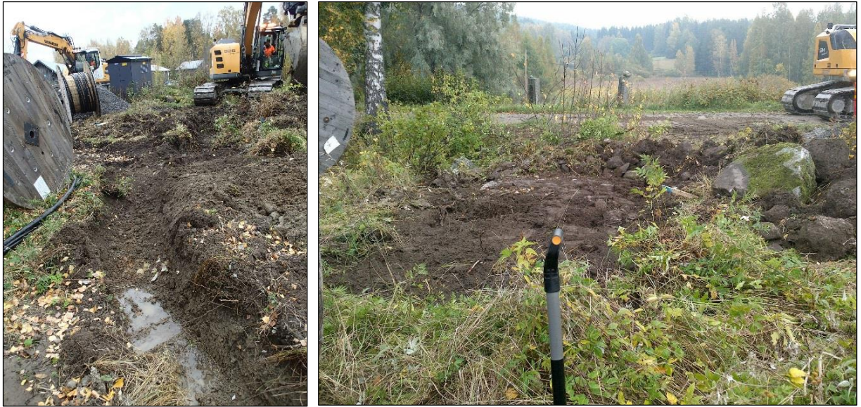
Vasen. Kaapeliojaa Kivisojantien länsipuolella, tien eteläpäässä. Kuva etelään. Oikea. Muuntamon paikka
