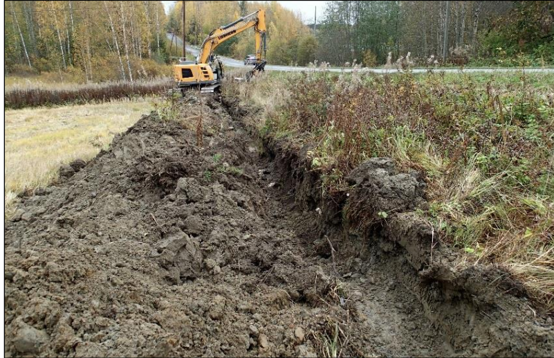
Kalkkistentien pohjoisreunaan kaivettu kaapelioja. Itä-Kaakkoon.
